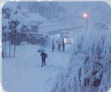
▲まだ暗いうちからの作業を始める (23日午前7時)
