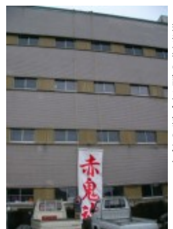
▶懸垂幕の設置作業の様子
